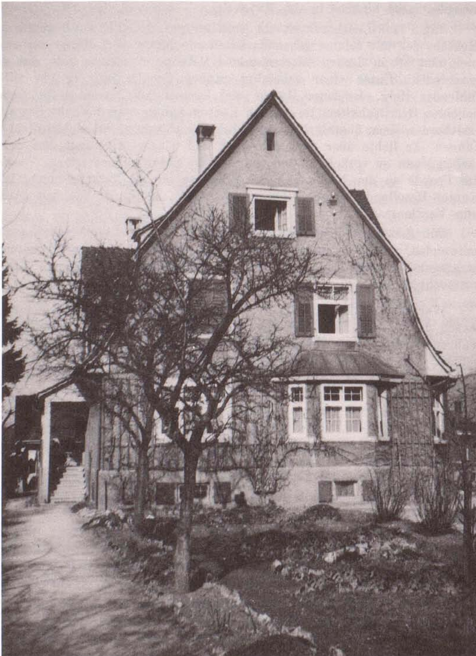
Das von Franz Leuthardt an der Burgstrasse in Liestal (in der Nähe der Bezirksschule) erbaute Haus.
