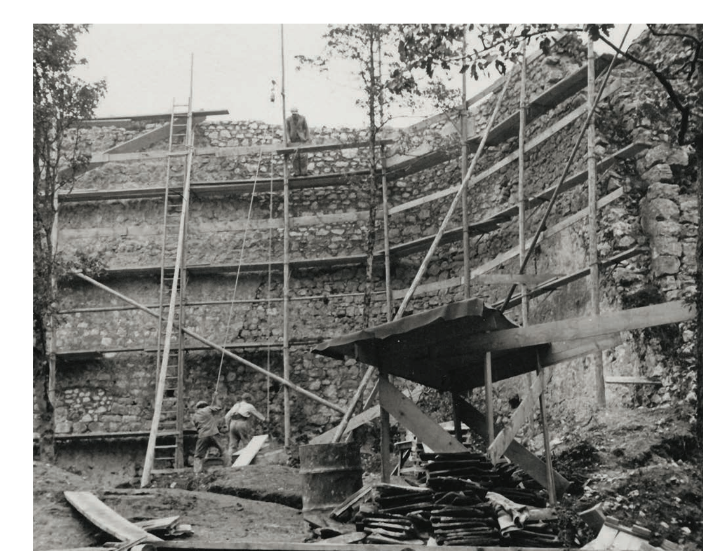
Sanierungsarbeiten an der Schildmauer in den 1930er Jahren unter der Leitung des Architekten und späteren Präsidenten des Schweizerischen Burgenvereins, Eugen Probst.
