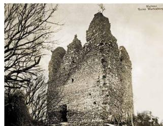
Eine Postkarte zeigt den Zustand der Mittleren Wartenberg vor der Restaurierung von 1934. Einige der Risse könnten im Erdbeben von 1356 entstanden sein (Foto digital bearbeitet durch Tom Schneider).
