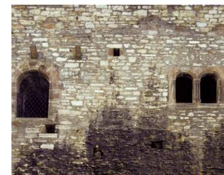
1934 wurde das zweite Obergeschoss des Wohnturms saniert und rekonstruiert. Die 1932 aufgefundene Drillings säule wurde dabei als Unterteilung eines Doppelfensters gedeutet, was heute kritisch beurteilt wird.
