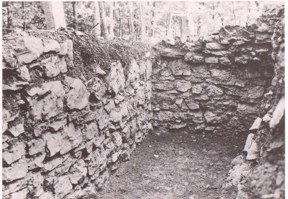
Abbildung 45 Äusserer Eingang, Blick nach Süden, mit noch nicht ausgeräumtem Schacht.
