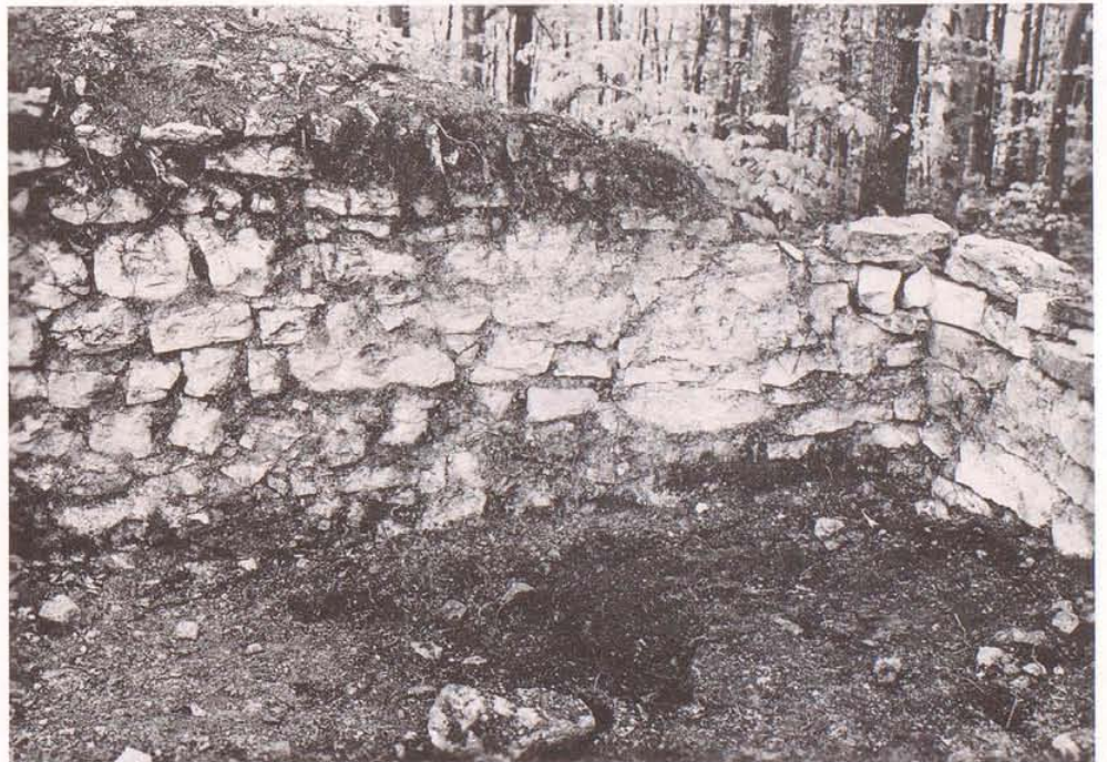
Abbildung 24 Südtrakt, Südostecke innen (z.T. ergänzt) mit Verputzresten (?).
