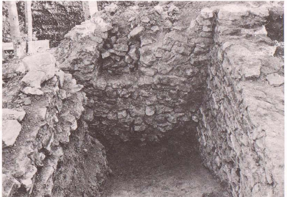
Abbildung 42 Zugangsgebäude. Blick nach Osten, mit dem engen inneren Eingang, rechts die in Bauphase 3 abgebrochene Mauer. Das Gelniveau war rechts auf Höhe der abgebrochenen Mauerkrone, das Schwellenniveau des Eingangs liegt etwas tiefer.
