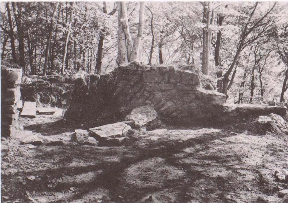
Abbildung 36 Südtrakt, Blick nach Süden, im Vordergrund die Fassung der Tankzisterne, dahinter die Quermauer mit Ansatz des Entlastungsbogens, der die Zisterne überspannt. Ganz rechts die Türschwelle des Zugangs zum Südraum.
