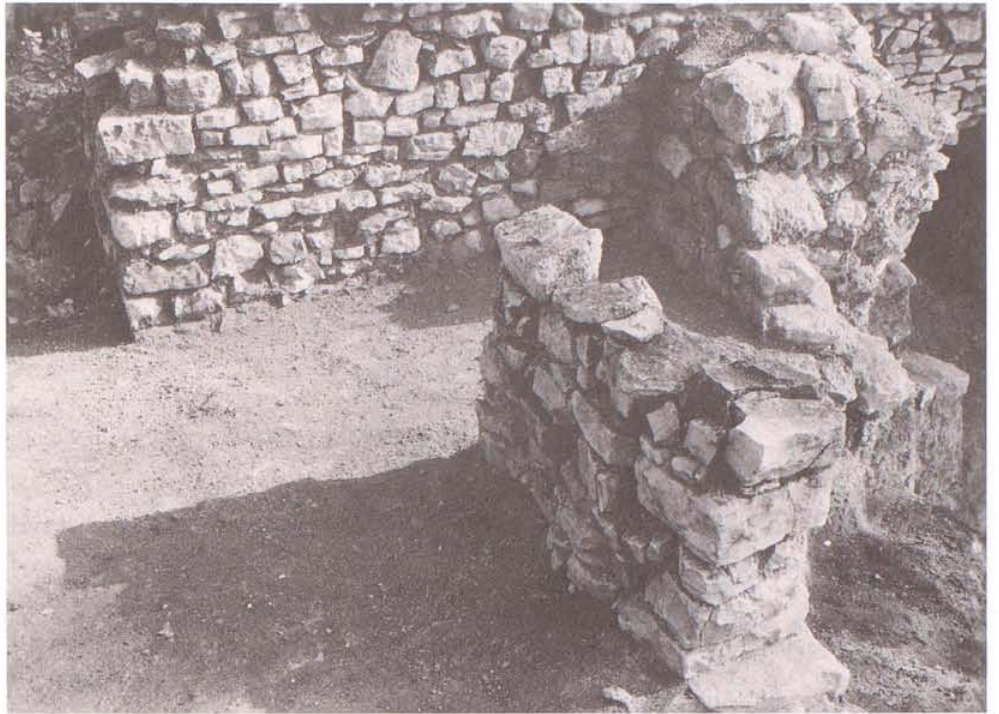
Abbildung 23 Südtrakt, Blick nach Südosten, mit Aussenmauer und Ecke des Eingangs (oben links), sekundär eingebauter Trennmauer (oben rechts) und Mauerklötz am Nordende der jüngeren Tankzisterne (Bauphase 2).
