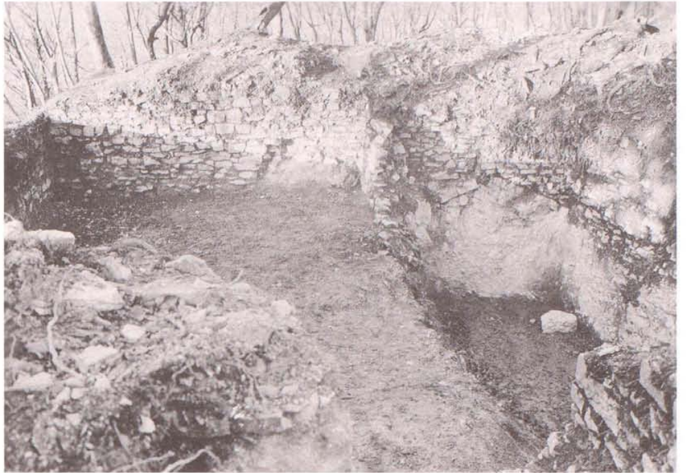
Abbildung 20 Der ausgeräumte Nordtrakt. Blick nach Norden, mit dem in den anstehenden Fels geschroteten Kellerraum rechts.
