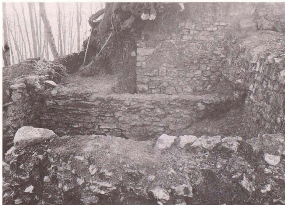
Abbildung 29 Zugangsgebäude, Blick nach Süden über die in Bauphase 3 abgebrochene Mauer an die Nordostecke des Kernbaus. Ganz rechts die Mauer des Zisternengebäudes (Bauphase 3).
