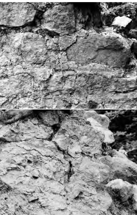
≈ 76 und ≈ 77 Verputz der Mauer M 12 mit fugenstrichähnlicher Behandlung des Fugenmörtels.
