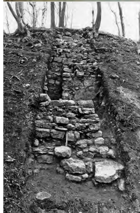
101 ≈ Torbau. Innenseite der Mauer M 8 mit gut erhaltenen Verputzresten, von Nordwesten.
