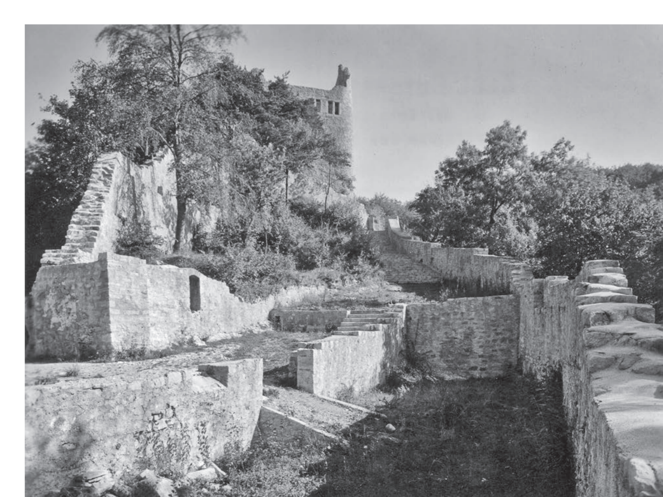
Westliche Vorburg nach den Restaurierungsarbeiten, 1939.
