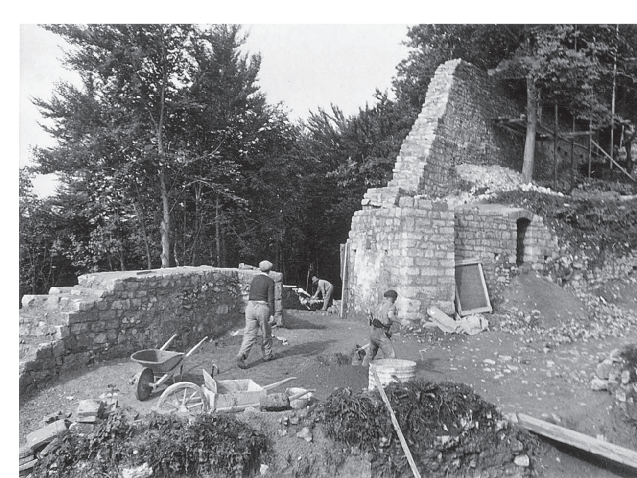
Restaurierungsarbeiten in der westlichen Vorburg, 1939.
