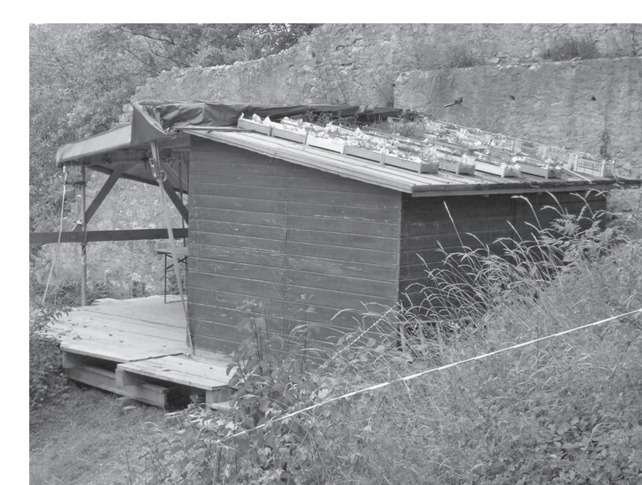
2008–2010 auf dem Dach der Baubaracke zwischen-gelagerter Mauerbewuchs.
