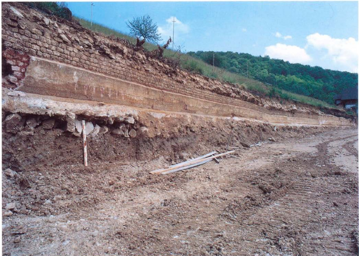
Abb. 20 Liestal Sonnhalde (08). Bergseitige Wand des Kanals von innen.
