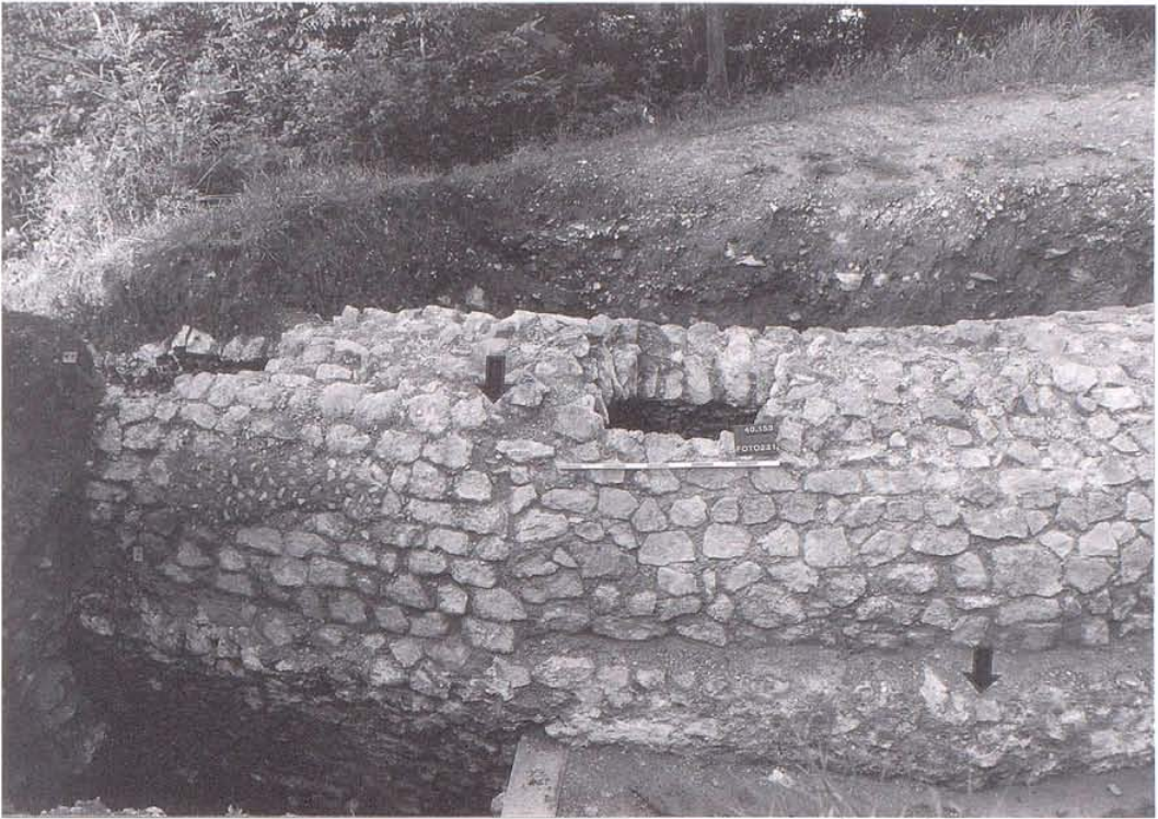
Abb. 40 Liestal Oberer Burghaldenweg (27). Detailansicht talwärts Richtung Südwest. Man erkennt deutlich den Knickpunkt in der Kanalwange (unterer Pfeil) sowie die weiter östlich liegende Anschlussfuge des Gewölbes (oberer Pfeil). Dieses konstruktionstechnische Detail im Bereich einer Baugrenze belegt die Zweiphasigkeit von Kanalmauer und Gewölbe, aber auch die Verwendung eines die untere Mauerfuge überlappenden Leegerüstes für die Gewölbeschalung (vgl. Abb. 2).
