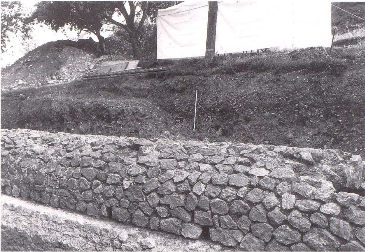
Abb. 27 Liestal Oberer Burghaldenweg (27). Gewölbemantel aus unregelmässigen Bruchsteinen.
