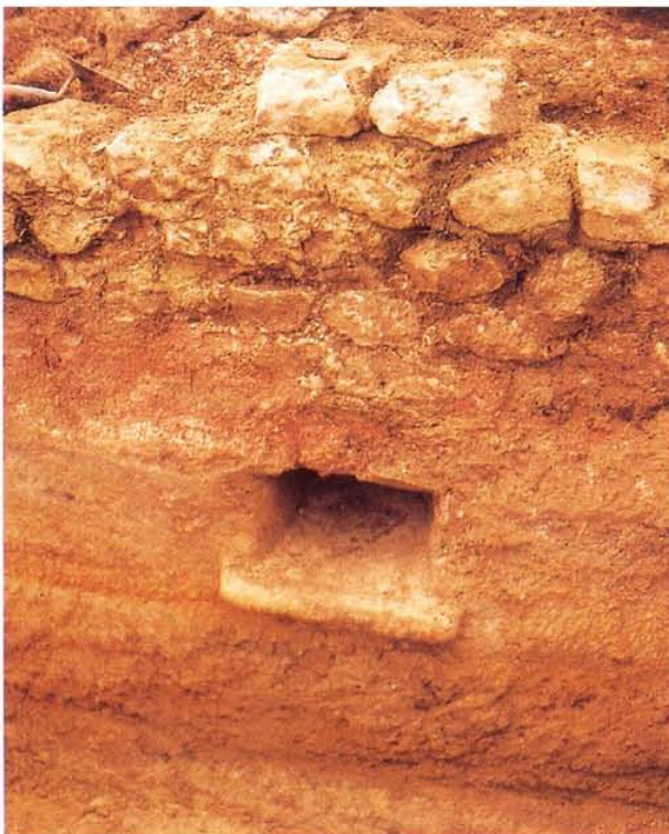
Abb. 23 Liestal Weideliweg (25). Einlauföffnung für einen seitlichen Zufluss.
