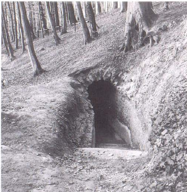
Abb. 37 Füllinsdorf Wölferhölzli (57). Südlicher Einstieg zum begehbaren Teil der Leitung.
