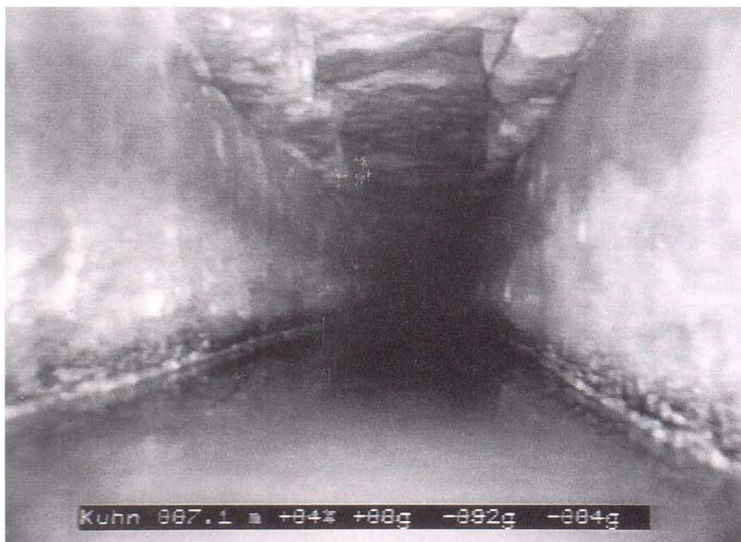
Abb. 6 Windisch, Kanton Aargau. Die noch heute wasserführende römische Leitung vom Birrfeld nach Vindonissa aus der Sicht des Kanalfernsehens.
