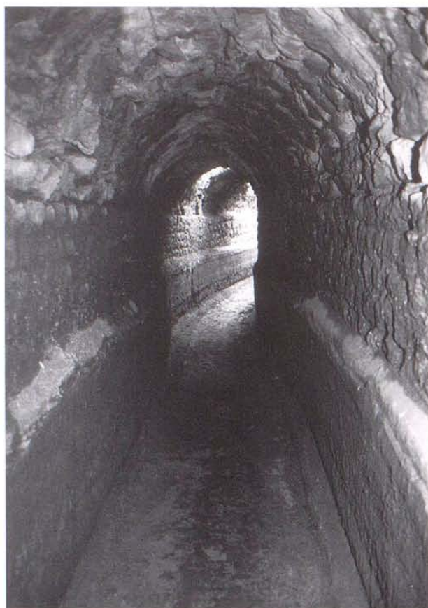
Abb. 25 Liestal Oberer Burghaldenweg (27). Blick in das noch erhaltene Gewölbe 1993.
