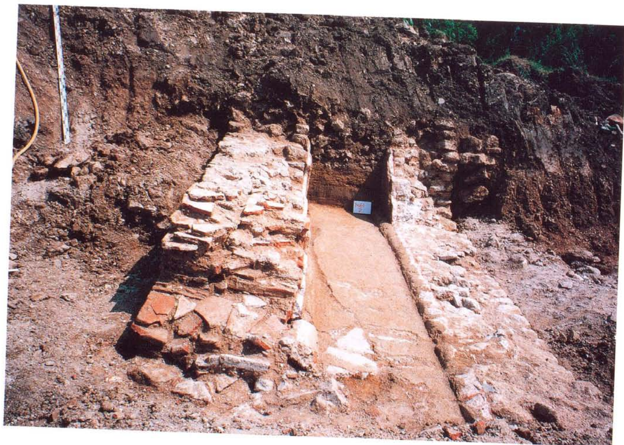
Abb. 28+29 Liestal Oberer Burghaldenweg (30). Sonderfall: Hier ist eine ganze Partie der hangeitigen Wange aus Leistenziegeln (Fehlbränden, Ausschussware) errichtet. Foto aus nordwestlicher Richtung und Aufsichtszzeichnung.
