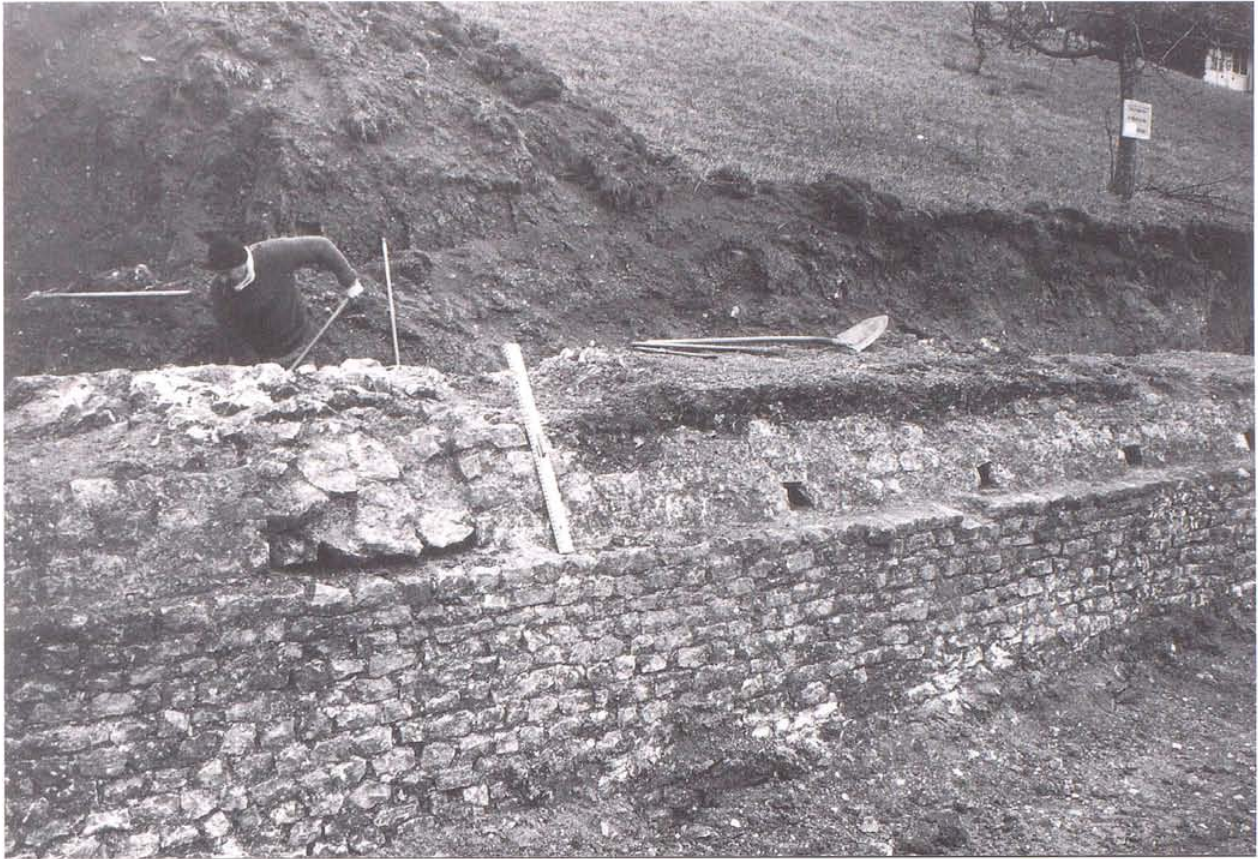
Abb. 19 Liestal Sonnhalde (08). Einstieg (links vom Masstab) und Balkenlöcher der Gewölbekonstruktion.
