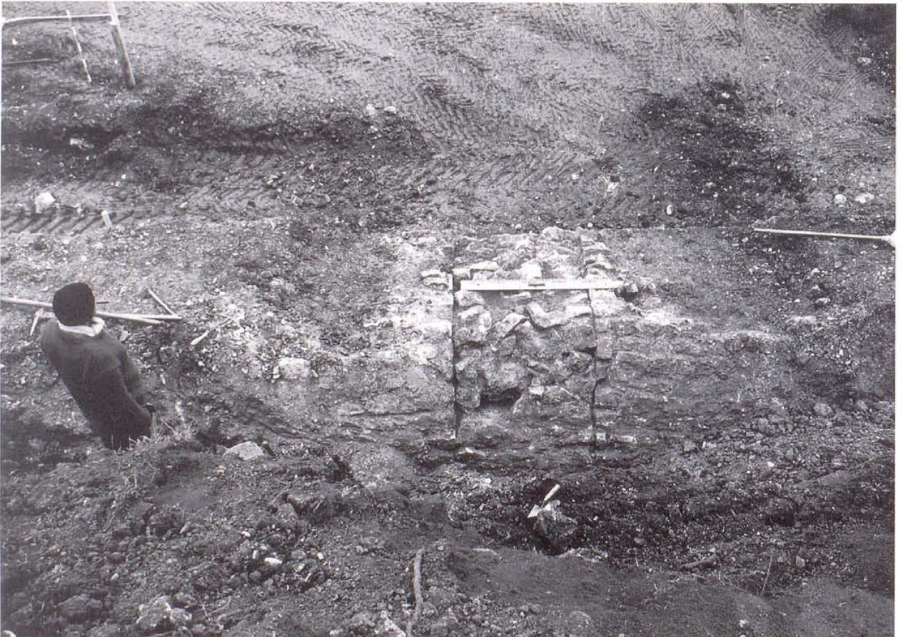
Abb. 18 Liestal Sonnhalde (08). Zugemauertes Einstiegloch.
