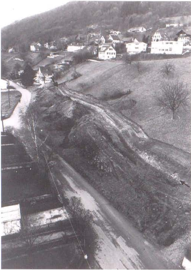
Abb. 17 Liestal Sonnhalde (08). Über 120 m Römische Wasserleitung sind oberflächlich freigelegt.
