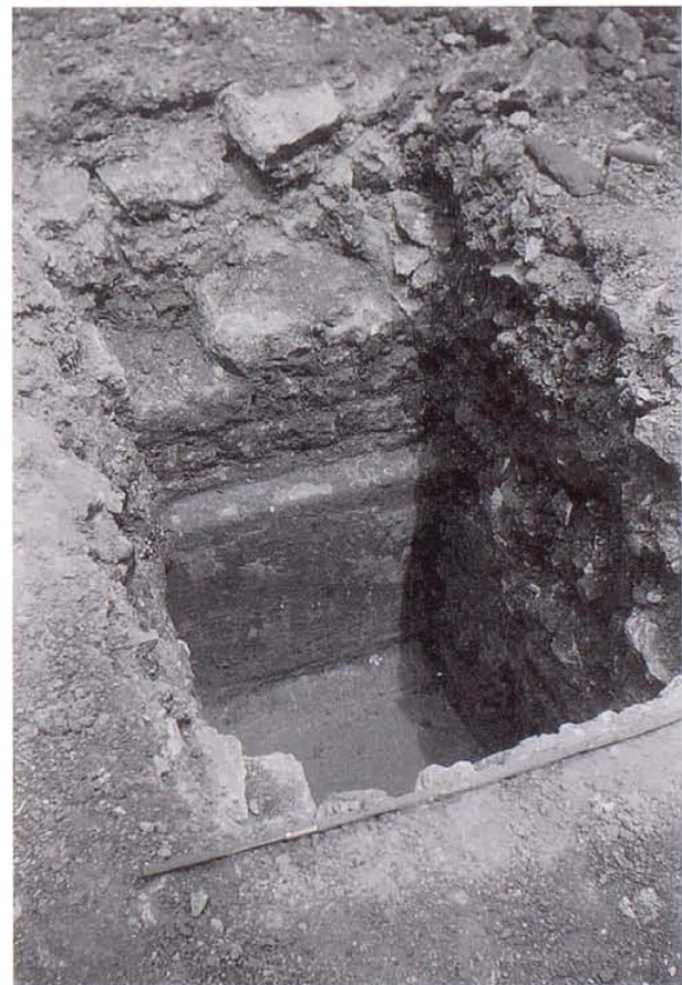
Abb. 13 Liestal Heidenlochstrasse (07). Blick in die Leitung mit eingestürzt Gewölbe.
