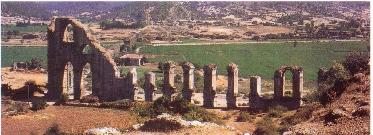
Abb. 9 Ablaufende Rampe und folgender Unterbau an einem der hydraulischen Türme von Aspendos (Türkei).
