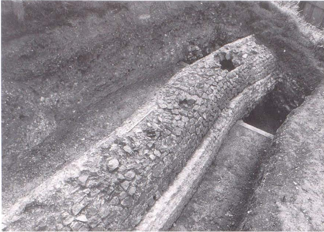
Abb. 2 Liestal Oberer Burghaldenweg (27). Treffpunkt zweier Baulose an der Biegung oder Knickung des «Tatzelwurms». Die Konstruktion von Seitenwand und aufgesetztem Gewölbe ist hier sehr klar erkennbar (vgl. Abb. 40).
