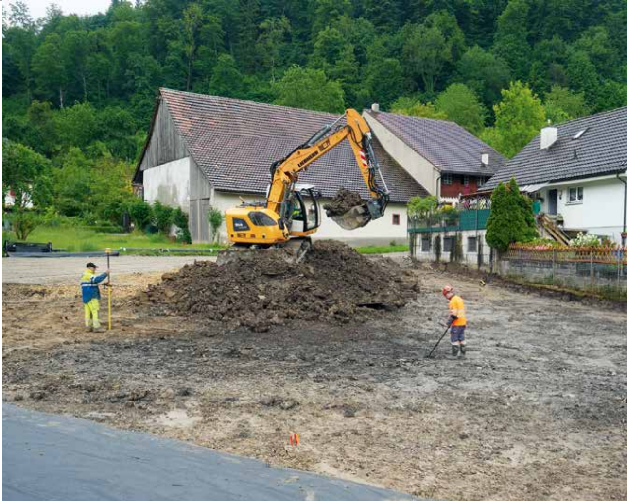
Eptingen, Läufelfingerstrasse 6. Der Bereich des römischen Fundhorizonts wurde auch mit dem Metalldetektor abgesucht. Blick nach Süden.
