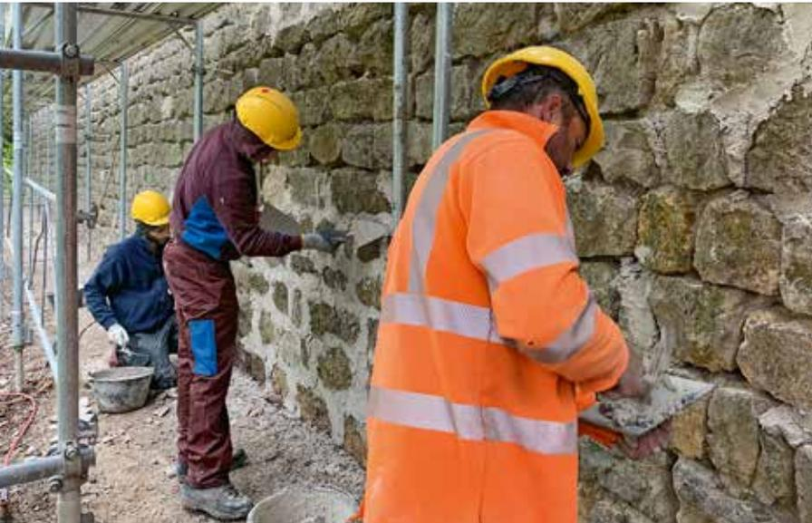
bruch der Firma Fontarocca AG in Reigoldswil bezogen. Im Weiteren erfolgte eine umfassende Neuverfugung des Mauerwerks und der Mauerabdeckungen. Wo immer nötig wurde dafür der ausgewitterte oder entsprechend gefährdete Fugenmörtel entfernt. Als Fugen- und Mauermörtel wurde eine Fertigmischung der Firma Röfix AG, der so genannte Bündner Burgenmörtel, verwendet. Dieser ermöglichte eine vereinfachte wie auch einheitliche Verarbeitung auf der Baustelle.
