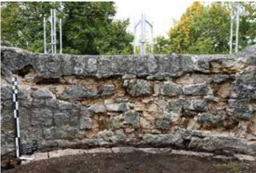
Schadensbilder, wie sie für die Farnsburg typisch sind: Die Innenwand des Blauen Turms nach Entfernung der frostzerstörten Mauersteine (ProSpect GmbH).
