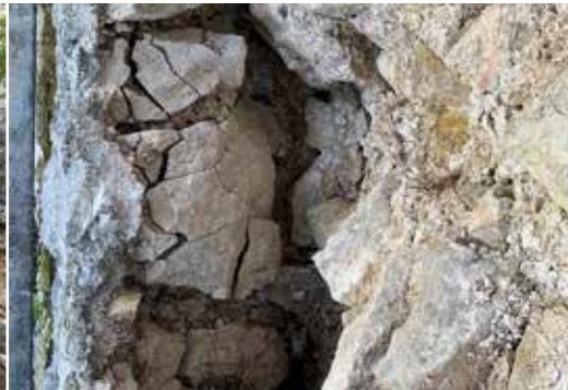
Ein vergleichbarer Schaden an der Ringmauer – nun in der Seitenansicht. Die Mauerschale ist durchgefroren und löst sich ab.
