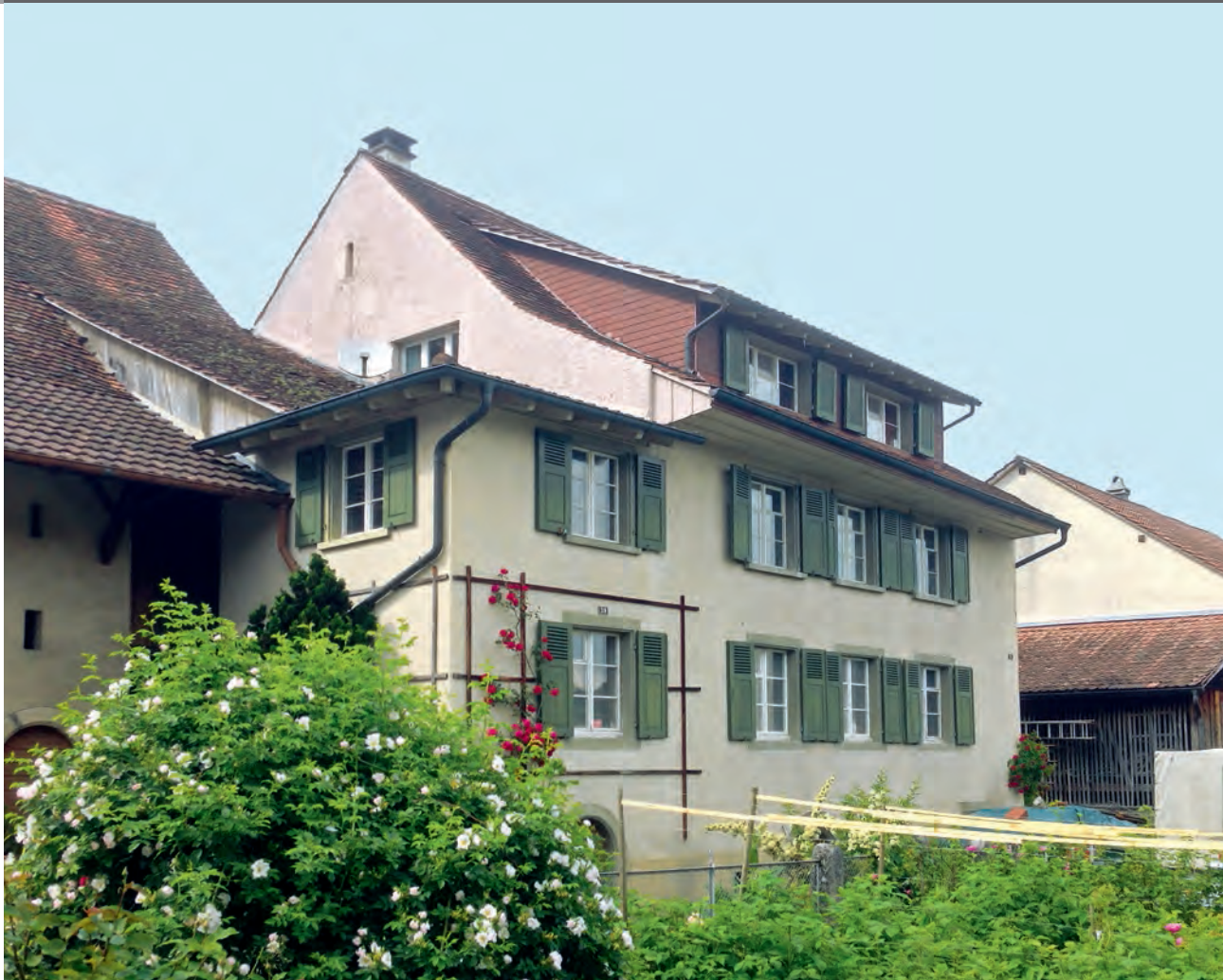
Benwil, Hauptstrasse 38. Strassenseitige Fassade mit vorgesetztem Erwei- terungsbau der Zeit vor 1749.
