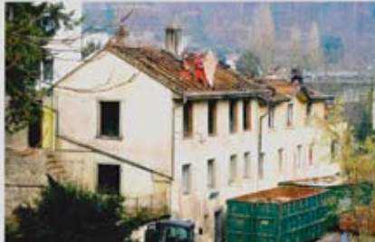
Neue Einbauten. Arbeiterinnen an der Baustelle im Brunngwegli 1 und 3 in Liestal.
