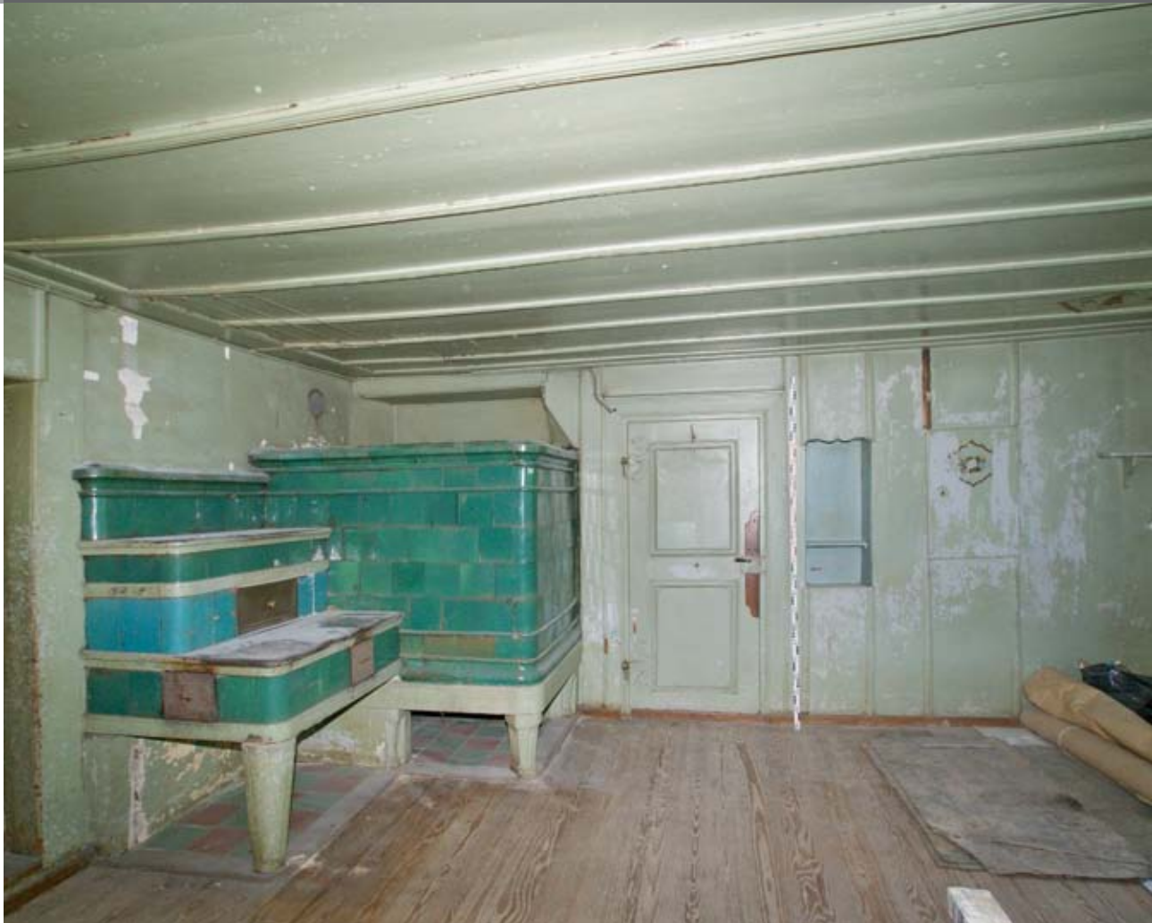
Gelterkinden, Tecknauerstrasse 17. Die Stube im Erdge- schoss mit Wand- und Deckentäfer.
