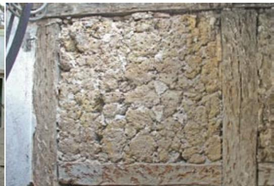
Oberwil, Hauptstrasse 36, interne Wand. Zur besseren Haftung des abschliessenden Mörtelputzes wurden in die Oberflächen der Lehmklumpen Löcher eingestochen.
