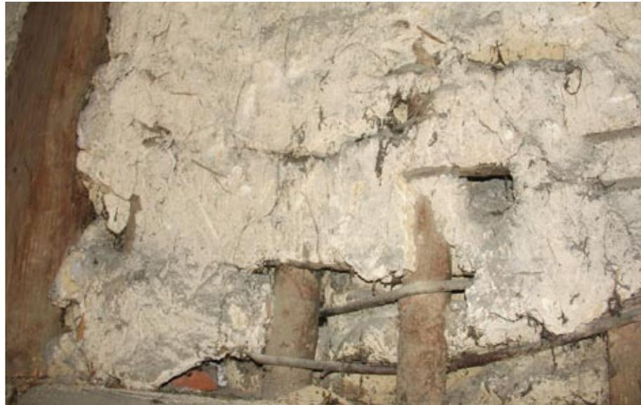
Oligozän und den eiszeitlichen Lösslehm zum bevorzugten Füllmaterial der Gefache. Lehm wurde für Aussen- wie Innenwände verwendet, teils gekalkt oder überputzt. Bereits ab zwölf Zentimetern Mächtigkeit bietet eine Lehmwand eine gute Wärmeisolation.
