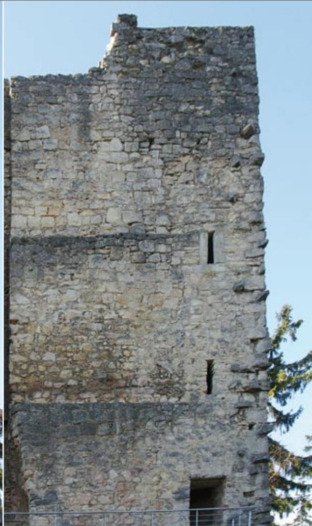
Durch die Fotoentzerrung können Objekte – hier die Schildmauer der Farnsburg – masstabsgerecht dokumentiert werden.
