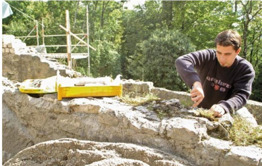
Am Westzwinger wird der zerstörte äussere Mauermantel mit frostbeständigen Steinen neu aufgebaut.
