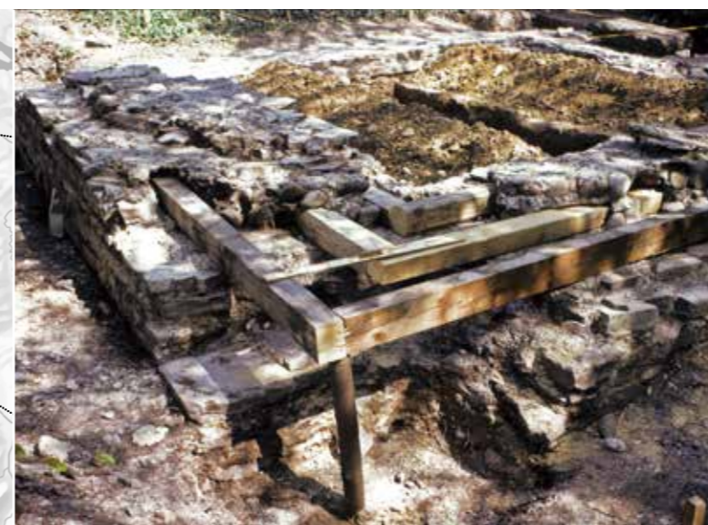
Mit modernen Kanthölzern rekonstruierter Balkenrost während der Grabung 1975. Der Einbau von Kant- und Rundhölzern diente dazu, den Turm während des Baus zu stabilisieren, was eine kürzere Bauzeit erlaubte.
