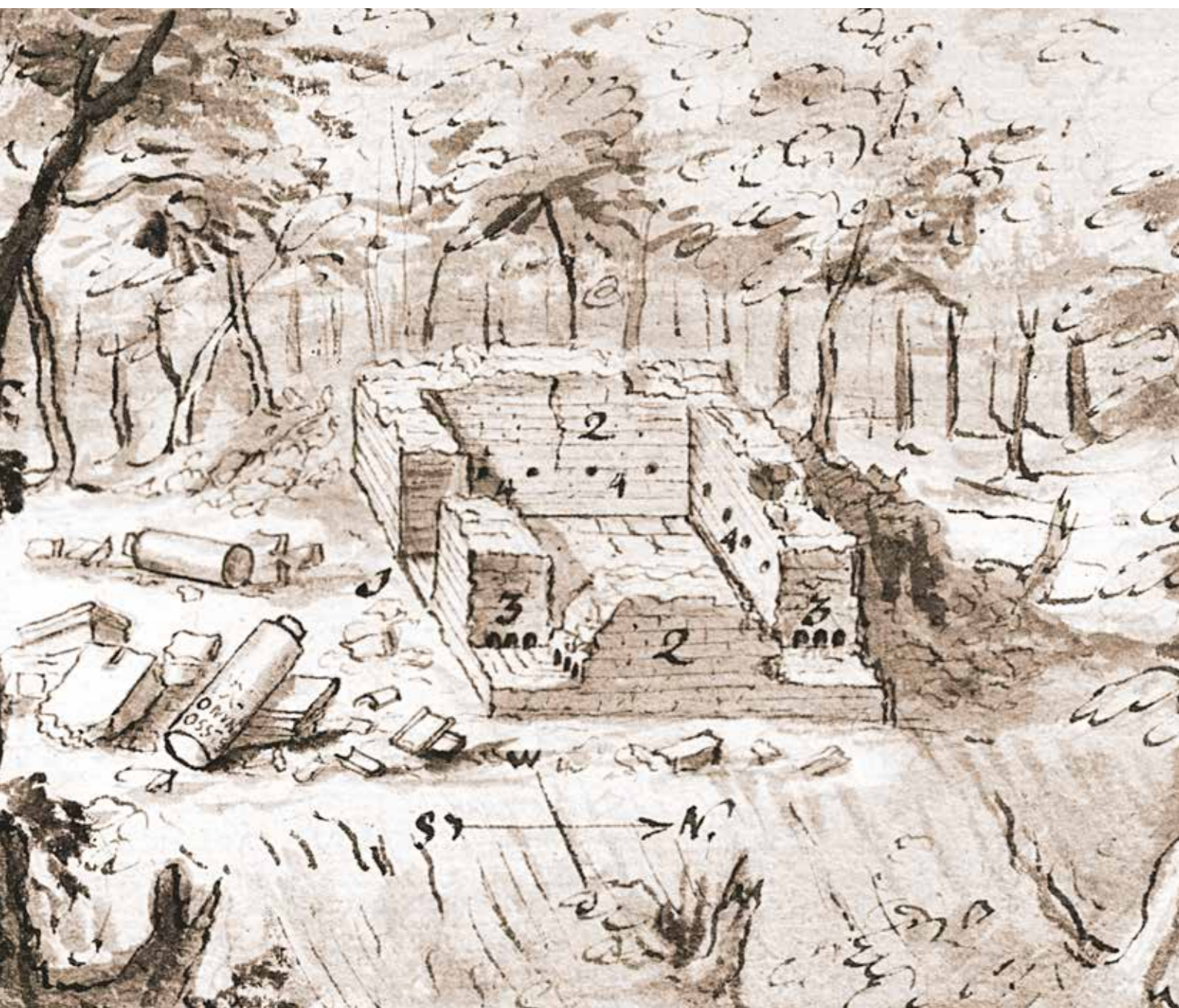
Zustand des Wachturms von Muttenz um 1750 (Ausschnitt aus einer Federzeichnung von Emanuel Büchel, Kupferstichkabinett Basel). Deutlich sind im Fundament die Hohlräume (Nr. 3) zu erkennen, welche die eingemauerten und im Laufe der Zeit vergangenen Holzbalken hinterlassen haben.
