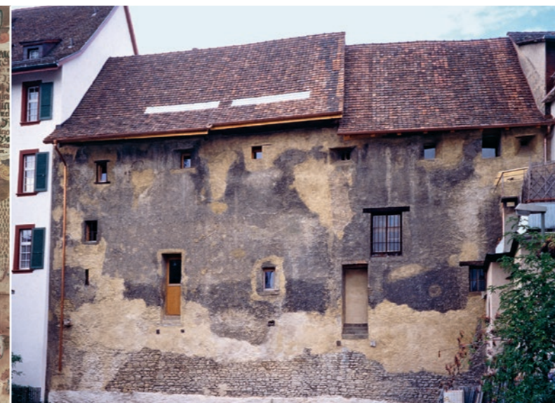
Die Stadtmauer Liestals im Bereich der Pfarscheune (2001). Die Untersuchungen aus dem Jahre 2001 ergaben, dass der Wehrgang nach einem Brandereignis erhöht wurde.
