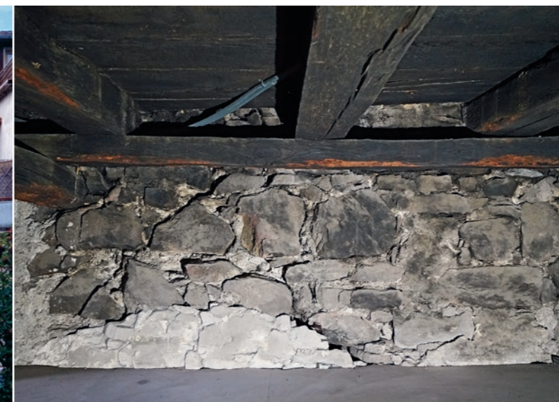
Mauerwerk mit der rundbogigen, zugesetzten Öffnung des ersten Torgebäudes und die darüber liegenden Deckenbalken von 1398/99 im Zwischenboden über der gotischen Stube.
