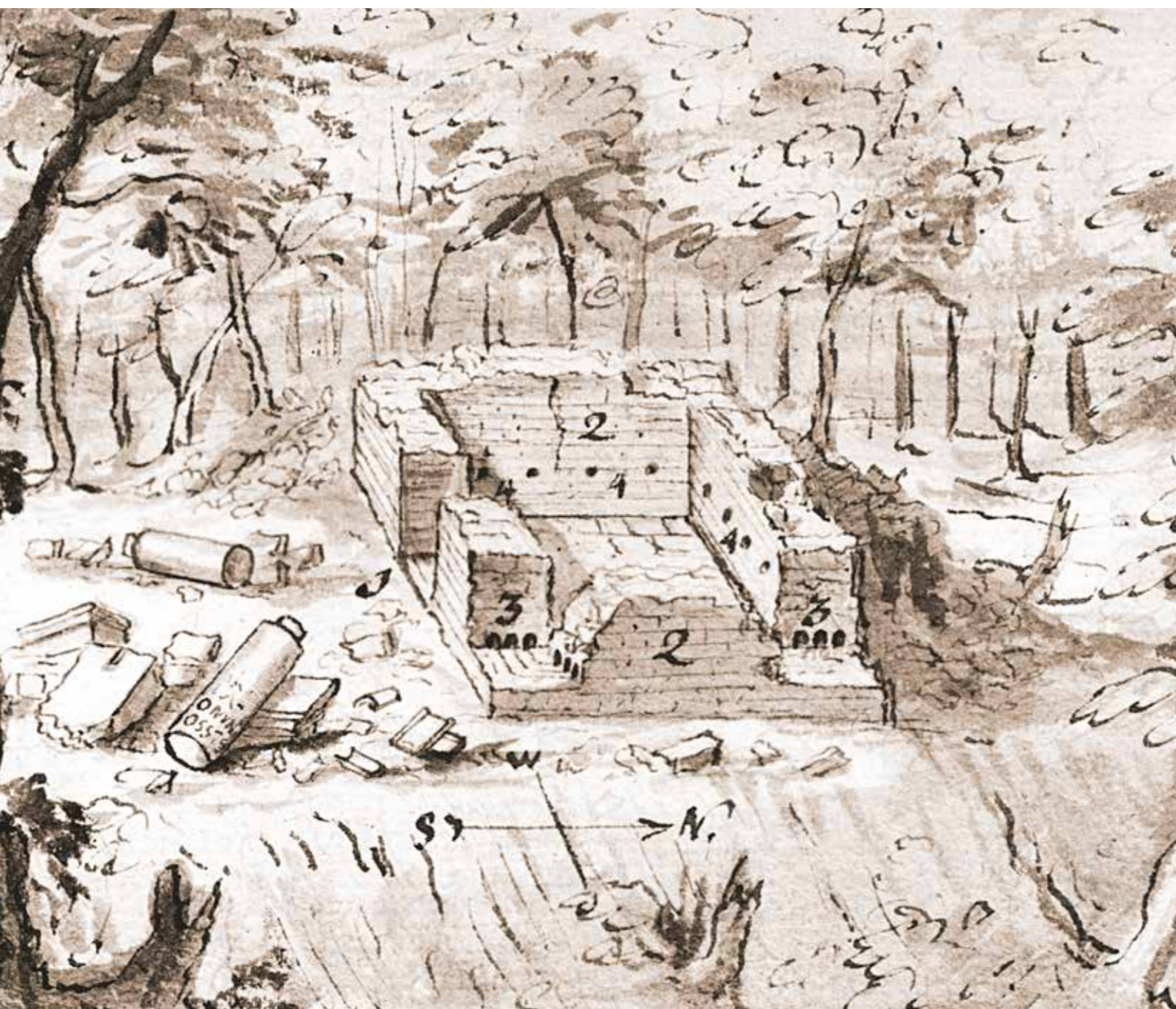
Zustand des Wachturms von Muttentz um 1750 (Ausschnitt aus einer Federzeichnung von Emanuel Büchel, Kupferstichkabinett Basel). Deutlich sind im Fundament die Hohlräume (Nr. 3) zu erkennen, welche die eingemauerten und im Laufe der Zeit vergangenen Holzbalken hinterlassen haben.
