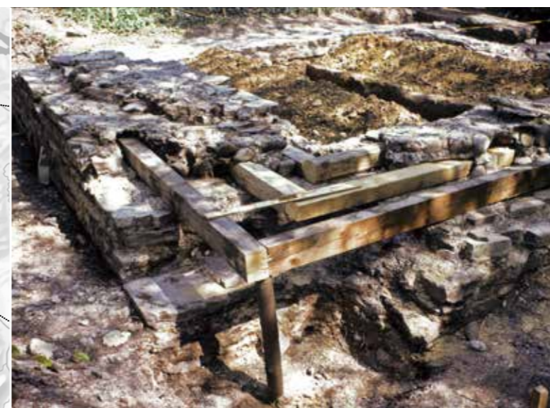
Mit modernen Kanthölzern rekonstruierter Balkenrost während der Grabung 1975. Der Einbau von Kant- und Rundhölzern diente dazu, den Turm während des Baus zu stabilisieren, was eine kürzere Bauzeit erlaubte.
